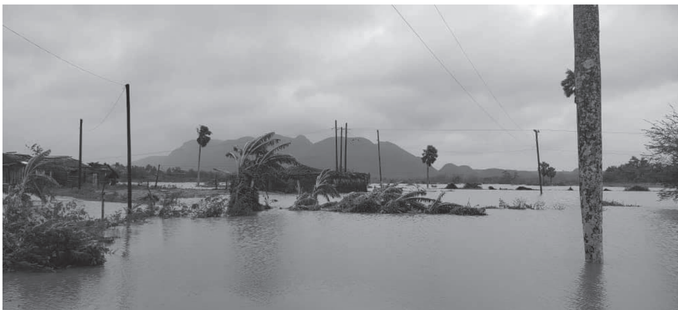
Hurrikan Ian führte zu schweren Schäden in der Landwirtschaft Pinar del Rios FOTO: TELE PINAR
