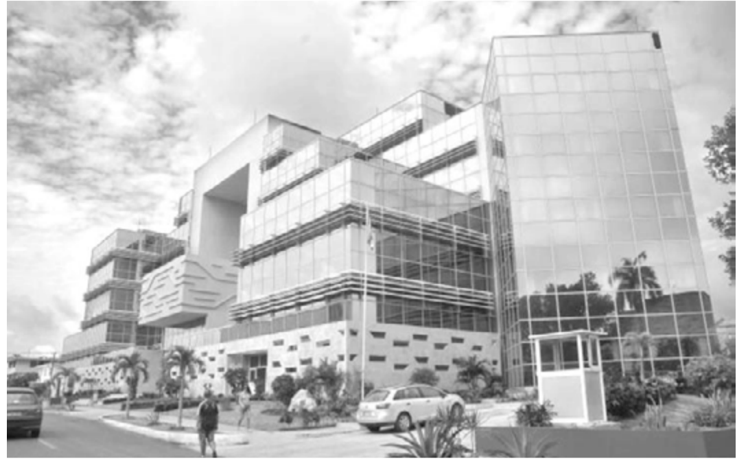
Die Verwendung von Glasfenstern ohne Sonnenschutz erhöht den Energieverbrauch in Gebäuden FOTO: ALBERTO BORREGO
