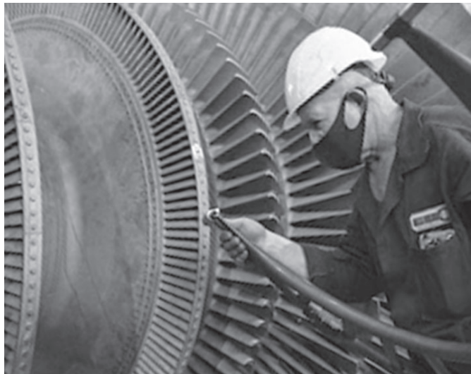
Die Arbeit derjenigen, die in den thermoelektrischen Anlagen arbeiten, ist heldenhaft. Es sind Männer und Frauen, die oft nach stundenlanger Arbeit nach Hause kommen und dann dort keinen Strom haben FOTO: JUAN PABLO CARRERAS VIDAL
