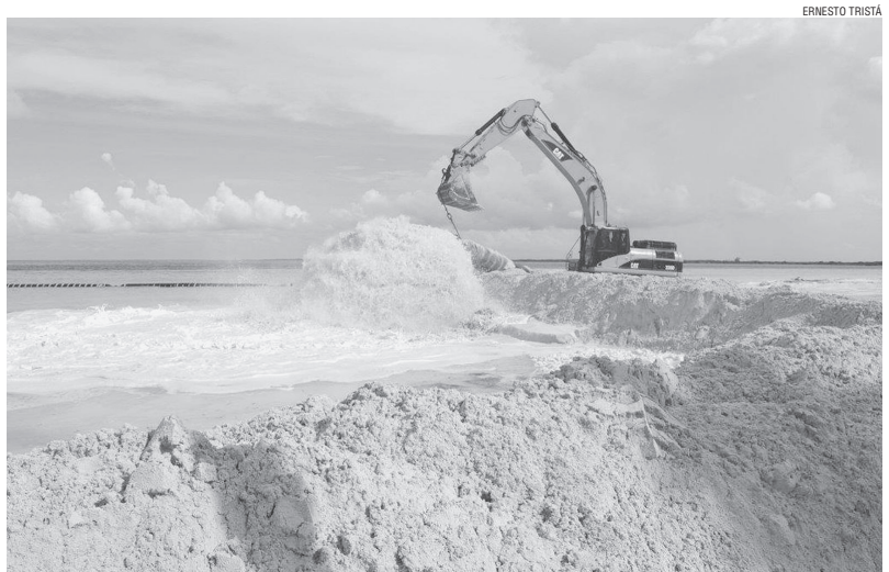
Das Aufschütten von Sand an der Küstenlinie der im Norden vorgelagerten Inselgruppe von Ciego de Ávila ist eine der Maßnahmen zur Bekämpfung der Erosion
