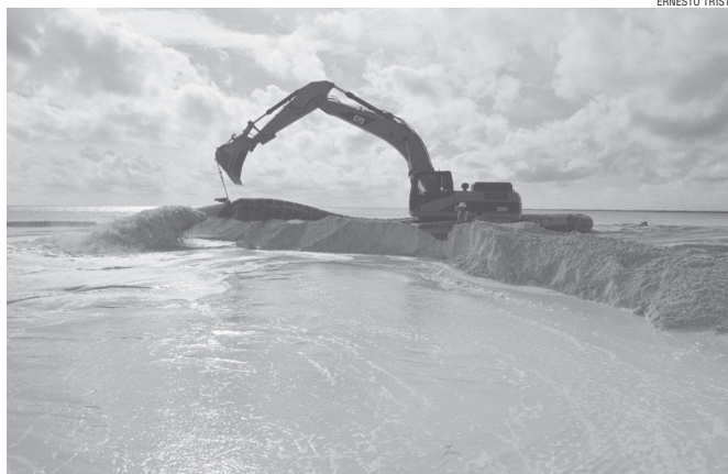
Die künstliche Sandzufuhr gilt als die vorteilhafteste technische Lösung, um der Erosion der Strände entgegenzuwirken
