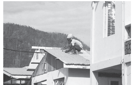
Der Wiederaufbau in Dominica geht langsam voran, macht aber vor allem in den Städten Fortschritte
