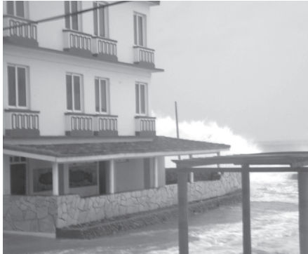
Überflutungen am Malecón von Baracoa, Guantánamo
