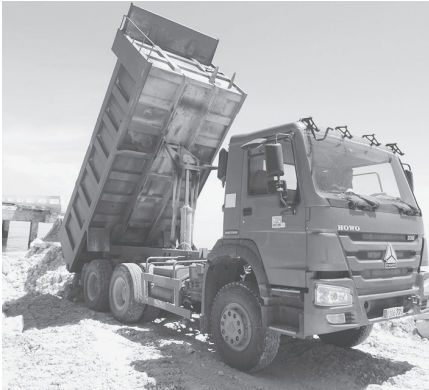
Arbeiten zur Behebung der Schäden an den Steindämmen, die das Festland mit den kleinen Inseln im Norden Mittelkubas verbinden
