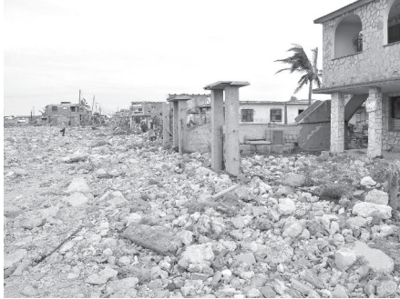
So hinterließ Hurrikan Irma ein Haus in der Gemeinde Santa Cruz del Norte in der Provinz Mayabeque
