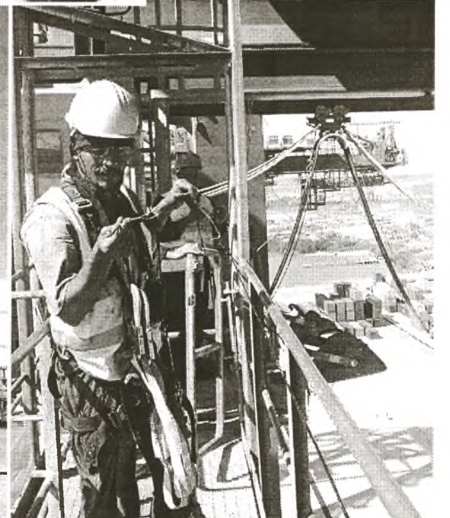
Arbeiter installieren ein Glasfaserkabel an einem Portalkran Typ STS
