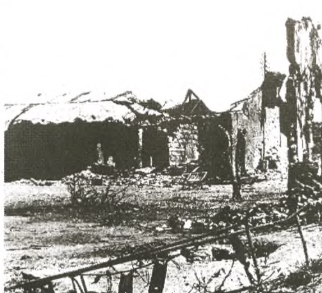
Der Zustand der Gebäude an der inneren Grenze der Umzingelung vermittelt einen Eindruck von der Intensität der Schlacht
