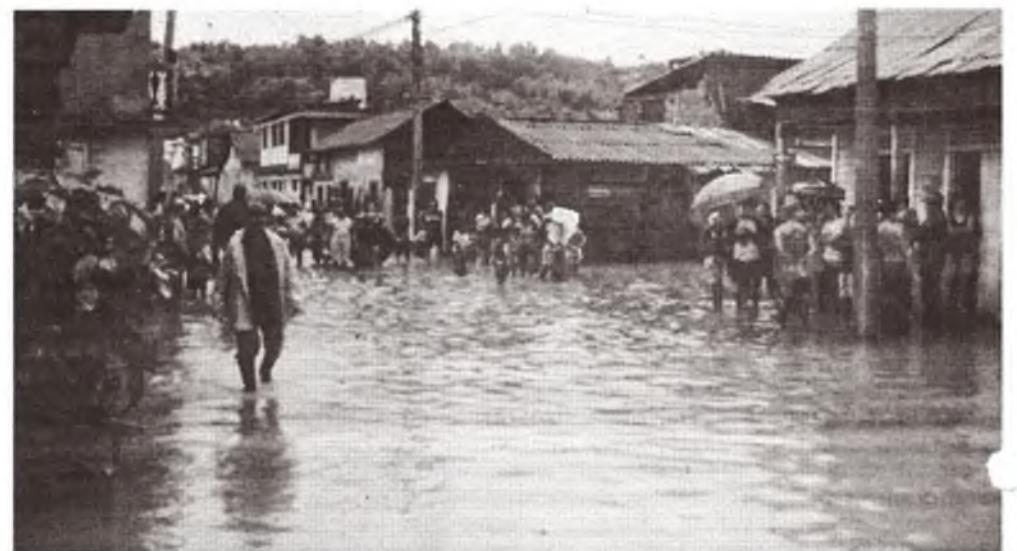
Überschwemmungen in einer Straße des historischen Zentrums der Stadt Baracoa, Provinz Granma
