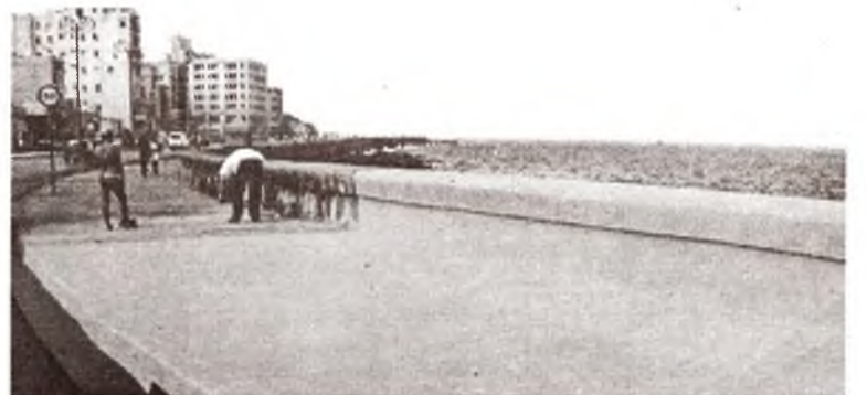
Ein Abschnitt der Uferstraße nach Abschluß der Sanierungsarbeiten
