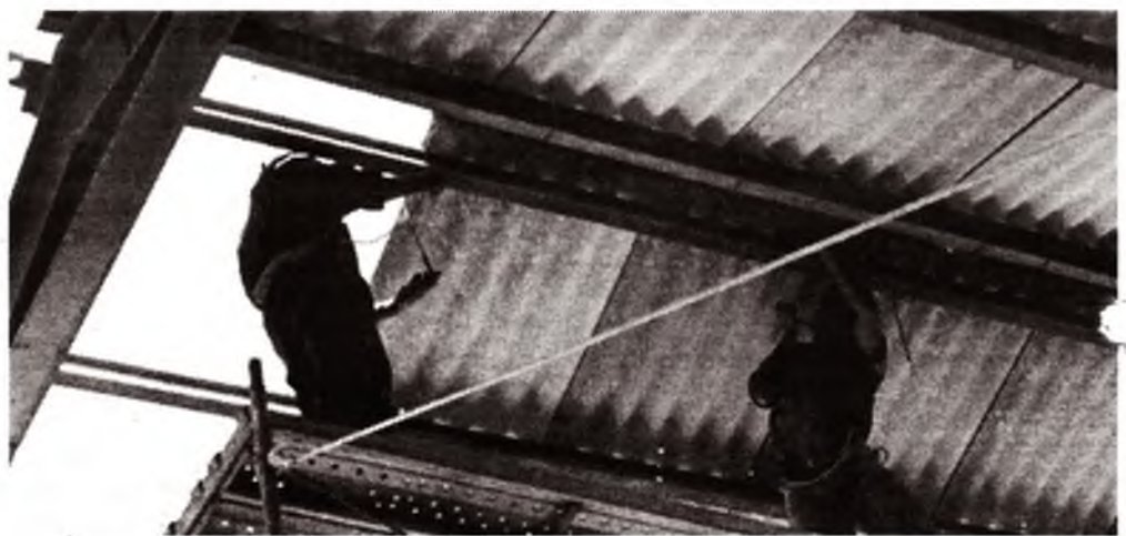
Die Arbeiter der Werft Alcides Pino beheben die Schäden an den Dächern und anderen Elementen der Einrichtung, um die Produktion wieder aufzunehmen
