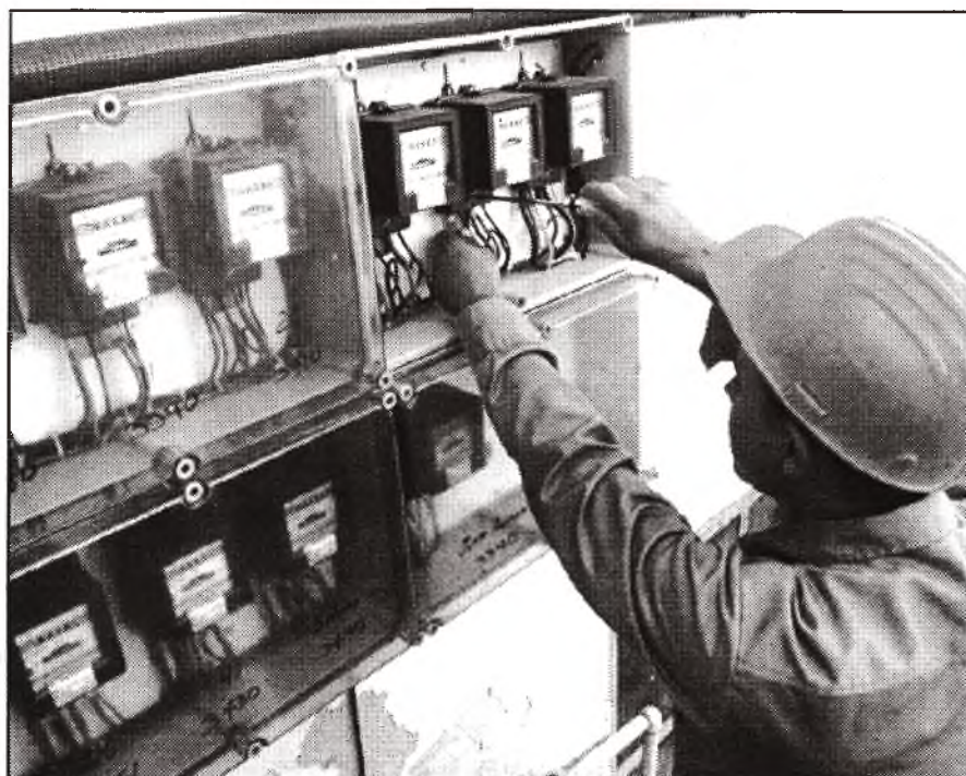
Stromzähler werden eingebaut
