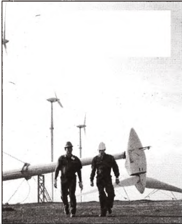
Der Park wurde mit einem Kostenaufwand von 3,4 Millionen Dollar mit französischer Technologie des Unternehmens Vergnet
