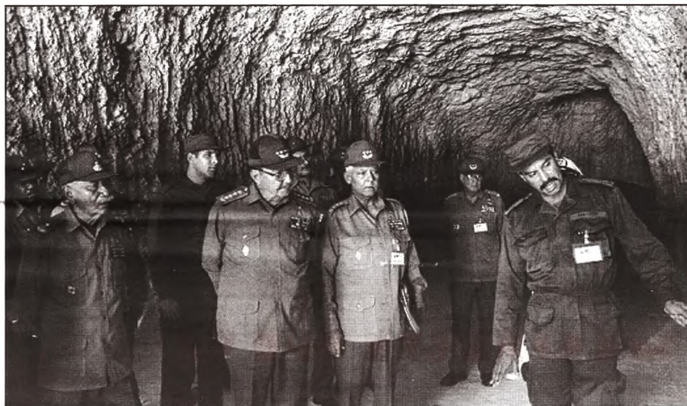
Kilometerlange Tunnel und andere Objekte wurden für die Verteidigung geschaffen
