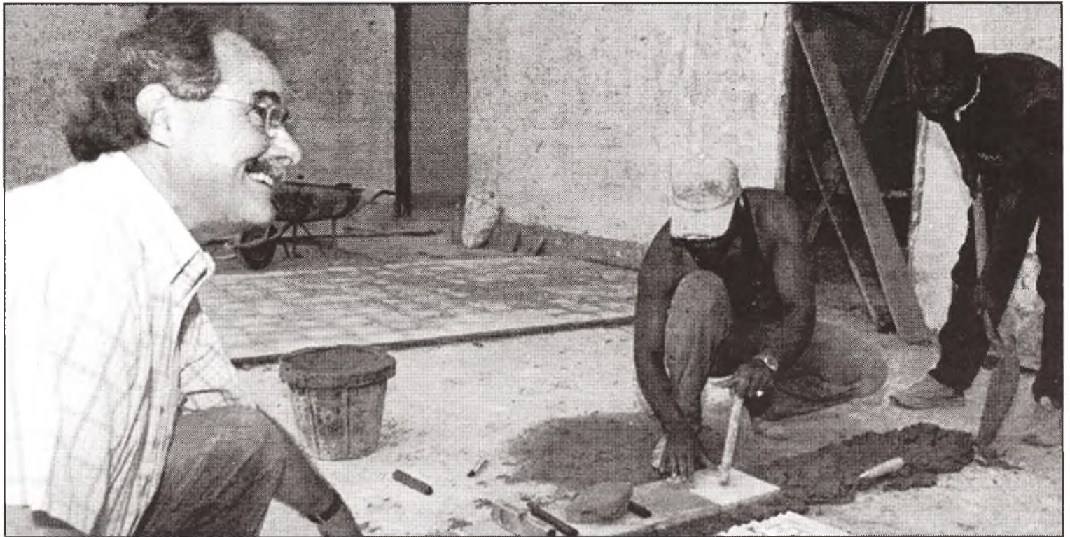
Sogar der Originalabstand der Fliesen wird beachtet, versicherte Enrique Hernández, der Chefprojektant
