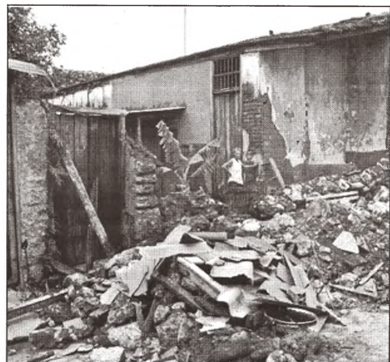
120.000 Häuser wurden durch den Wirbelsturm stark beschädigt
