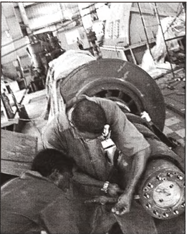
Neben Reparaturen wird im Kraftwerk Este de La Habana eine Modernisierung in Höhe von 20 Millionen Dollar vorgenommen
