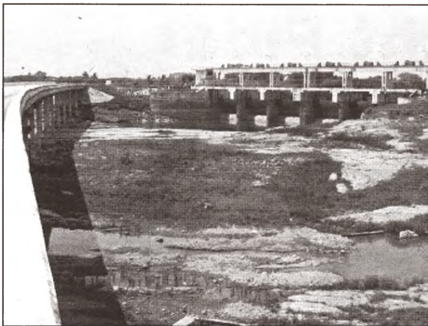
Blick auf den Überlauf des Zaza-Stausees, der heute nur über ca. 300 Millionen Kubikmeter Wasser verfügt
