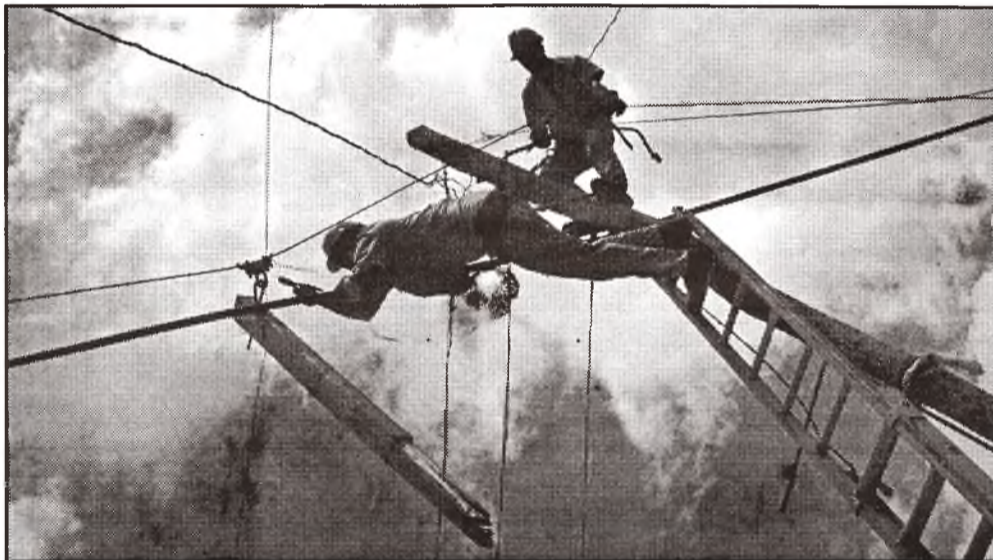
Hochspannungsspezialisten reparieren die Leitungen des Verbundnetzes
