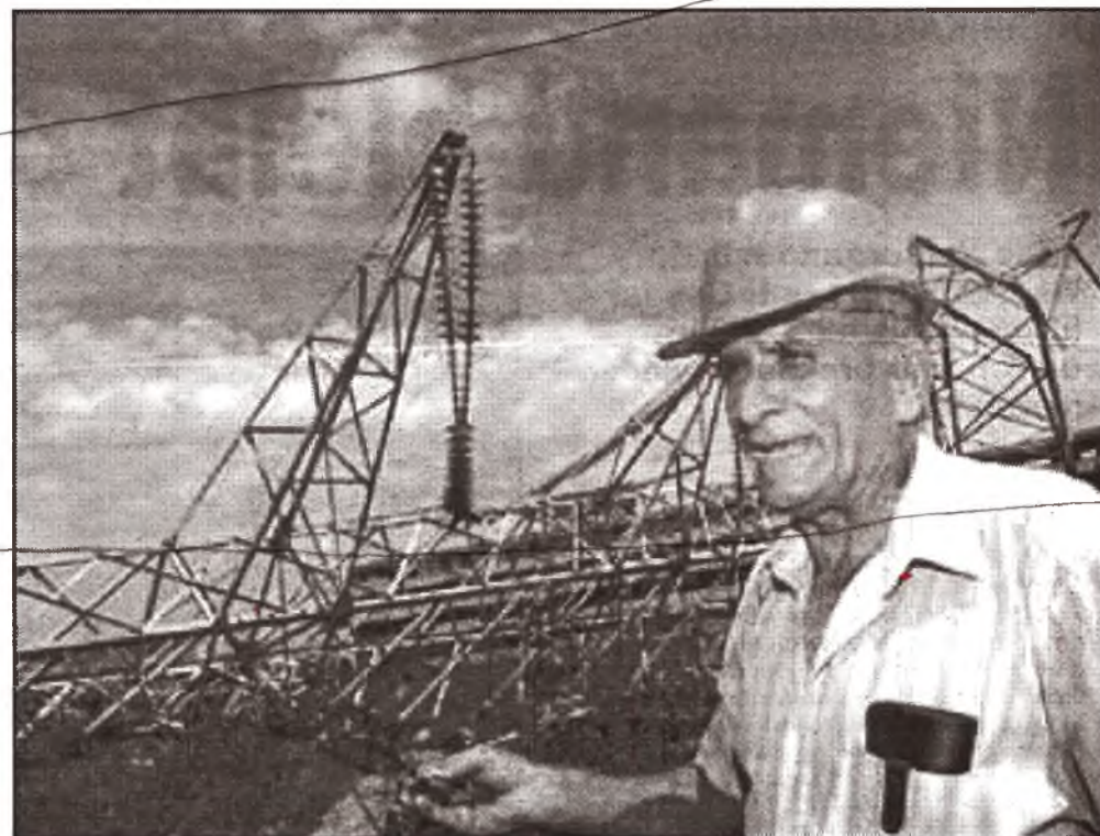
Die Provinz Pinar del Rio wurde vom Stromnetz getrennt. 13 Hochspannungstürme waren umgestürzt
