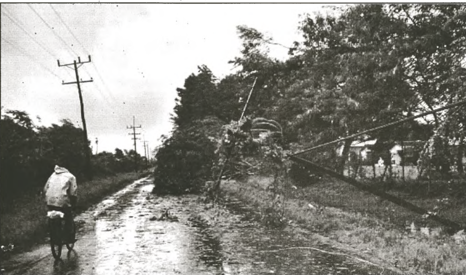
Zerstörte Stromleitungen in Pinar del Río
