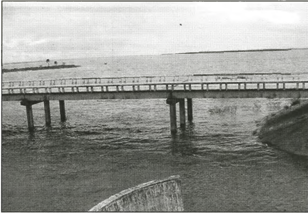
Der Stausee Zaza, der größte des Landes, mit einer Kapazität von über einer Milliarde Kubikmeter Wasser
