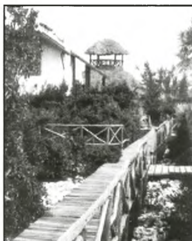
Die Villa Las Brujas, entstanden aus leichten Baustoffen inmitten der Natur
