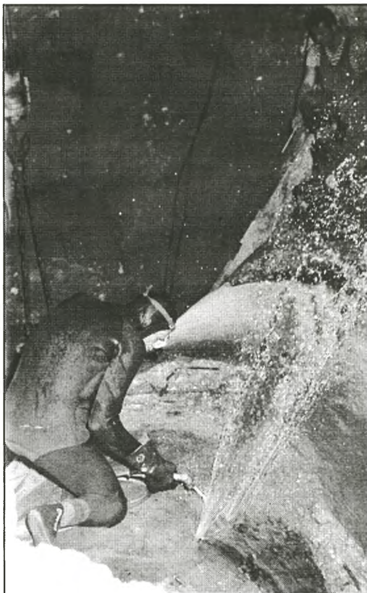
In diesem Jahr sollen 55.000 Rohrbrüche saniert werden
