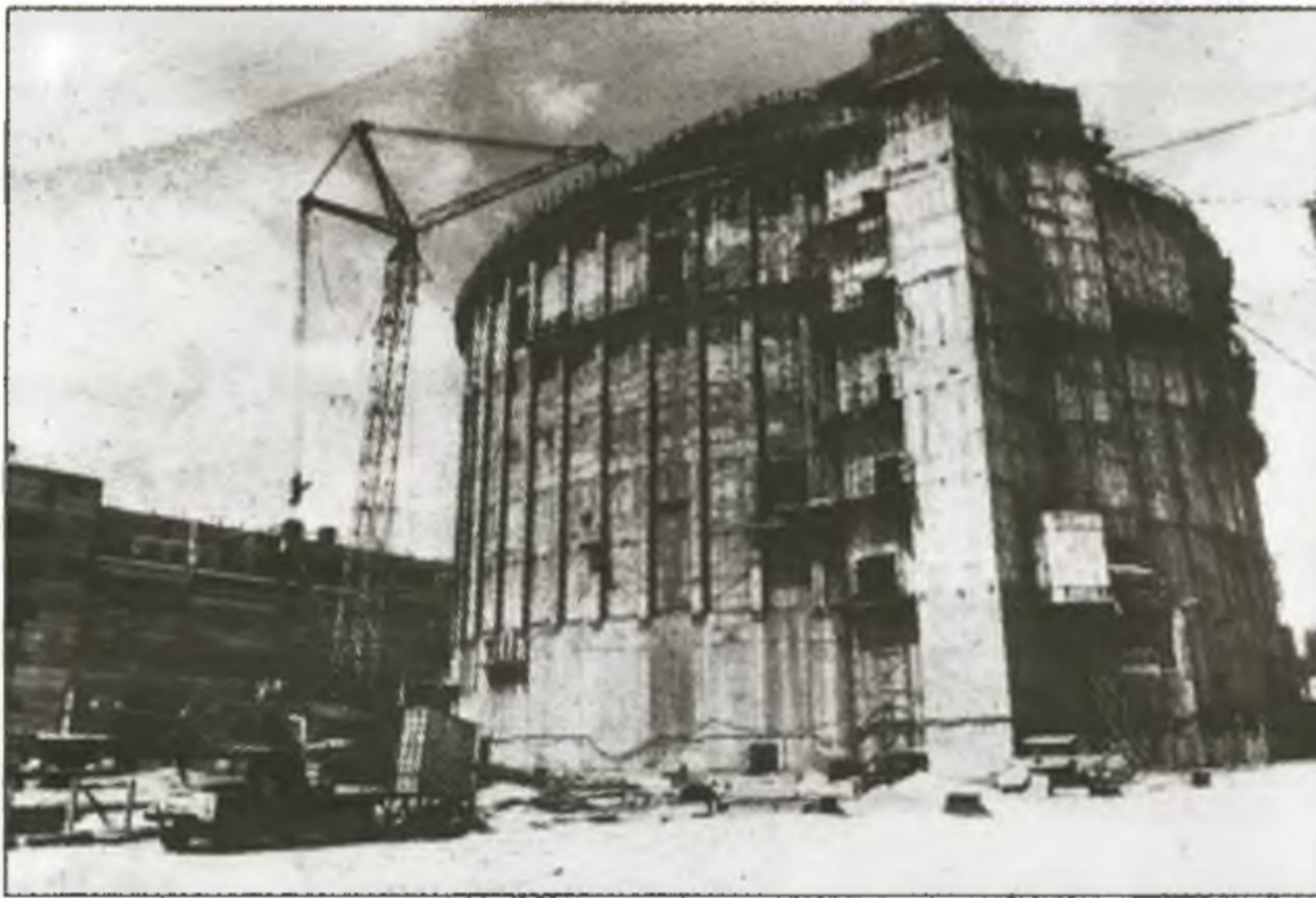
Das im Bau befindliche Kernkraftwerk Juraguá in Cienfuegos
