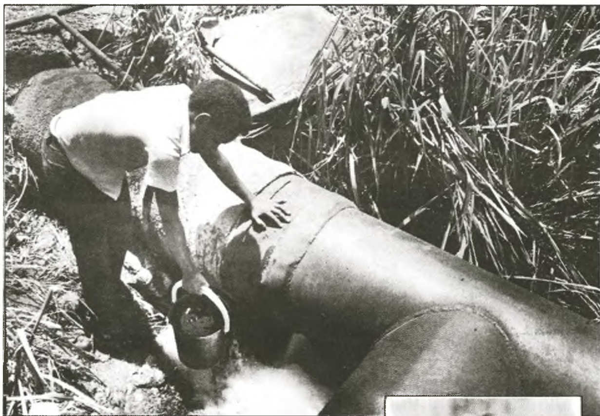
Havanna verliert fast die Hälfte seines Wassers durch den schlechten Zustand des Versorgungsnetzes
