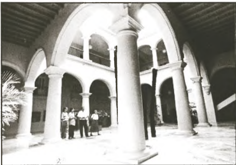
Die Säulen wurden neu errichtet, um Einsturzgefahren bei den Restaurierungsarbeiten auszuschließen. Originalmarmortelle und die Mudejardecken des Obergeschosses konnte man wiederverwenden.
